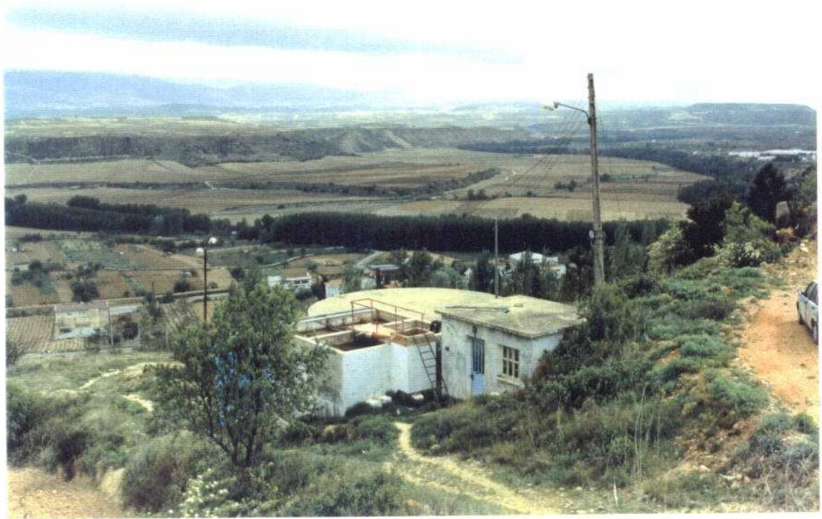
PLANTA DEPURADORA Y DEPOSITOS GRANDES DE CENICERO.
